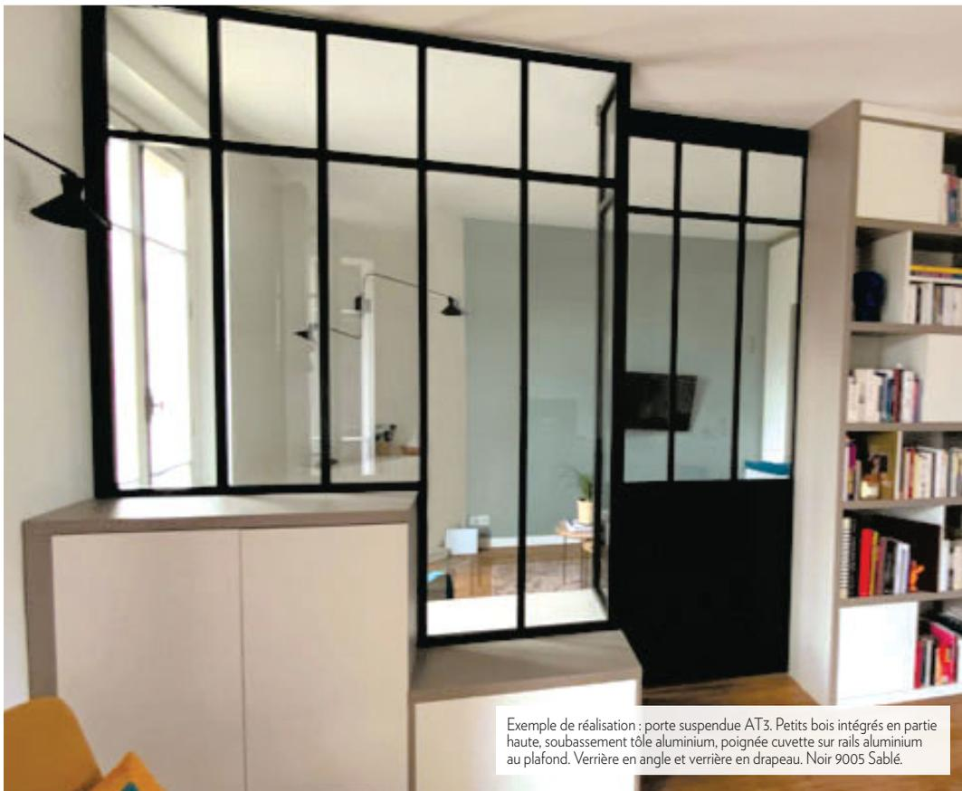
Exemple de réalisation : porte suspendue AT3. Petits bois intégrés en partie haute, soubassement tôle aluminium, poignée cuvette sur rails aluminium au plafond. Verrière en angle et verrière en drapeau. Noir 9005 Sablé.
