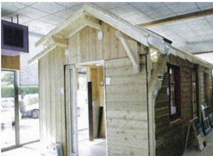
Au cœur de la salle d'exposition, une maison à ossature bois met en scène tous les procédés d'isolation et de revêtement
